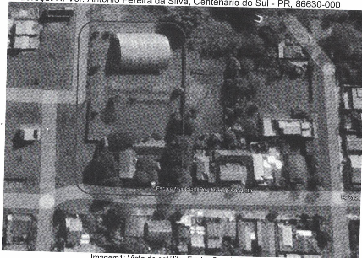
Imagem1: Vista de satélite. Fonte: Google Earth.
